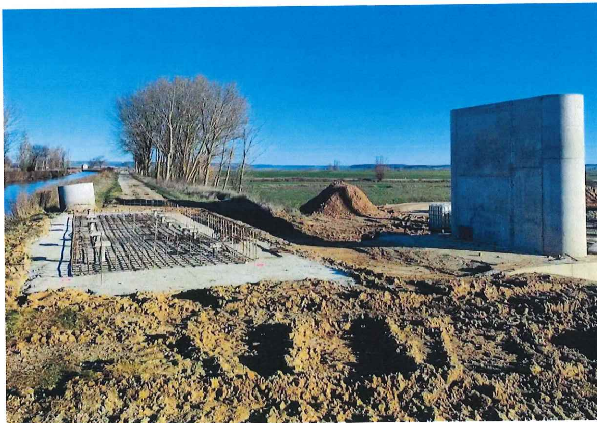
Foto de las obras del viaducto del Canal de Castilla. Febrero 2024.
